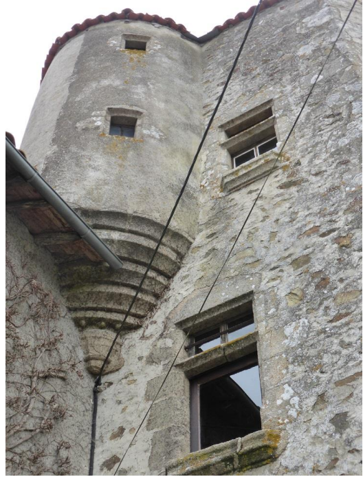
Partie haute de la tourelle d'escalier
