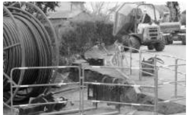
Passage de la conduite de gaz Cirières-Moncoutant
